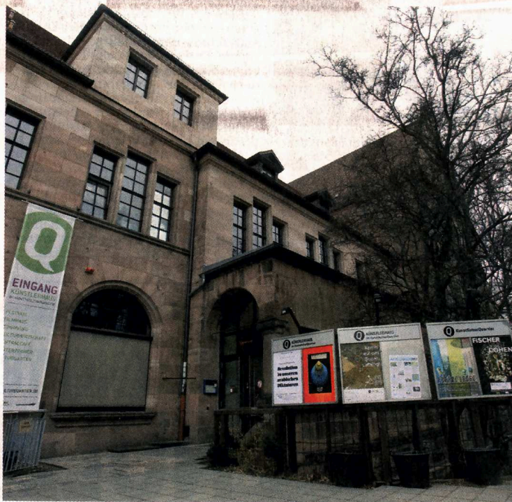
Das Nürnberger Künstlerhaus am Königstor ist Herzstück des KunstKulturQuartiers und im hinteren Teil marode. Die Parteien sind sich einig, dass saniert werden muss. Die Kostenschätzungen dafür liegen bei 22,5 Millionen Euro. Foto: Hippe
